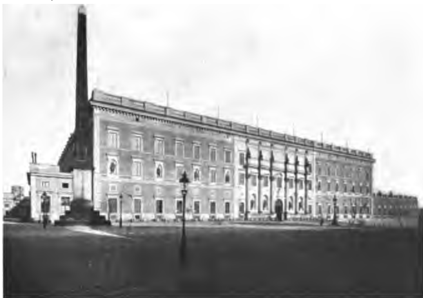
Château de Stockholm (façade méridionale).
